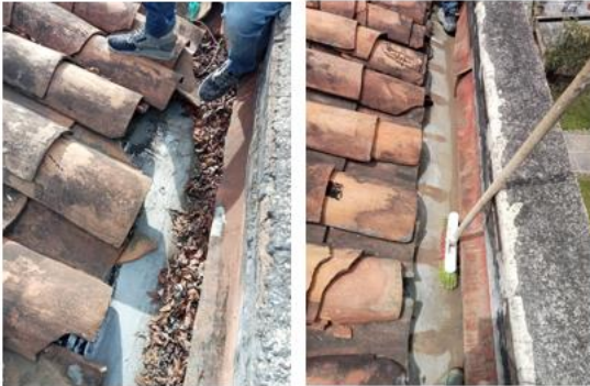
ARREGLO DE CANOAS, SE COLOCO NUEVA TELA ASFÁLTICA Y SE ELIMINO LA HUMEDAD HABITACION 201 (AGOSTO)
